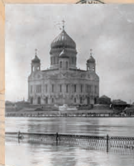
Фото Н. Г. Топазова. Храм Христа Спасителя до разрушения
